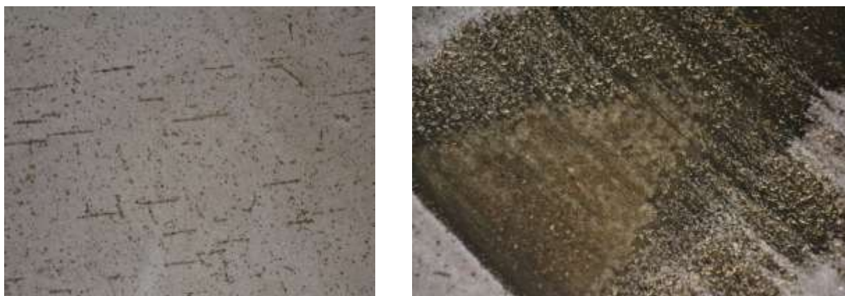
Figur 2.16 Ytligt slitage efter dubbdäck och burnout på Akryl Silikal Dekor efter 4 år på parkeringsdäcket i Åkeshov
