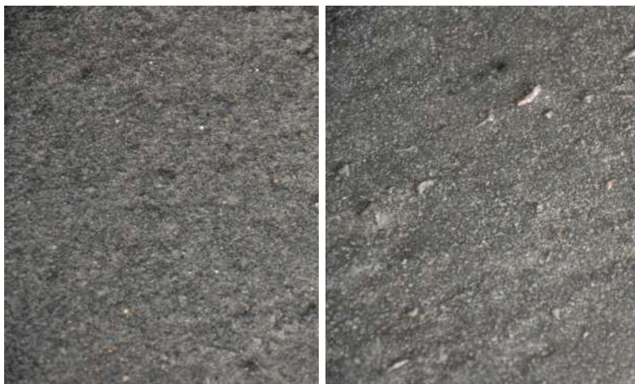
Figur 2.2 PGJA med vax och bromatta efter 5 år på parkeringsdäcket i Kville
