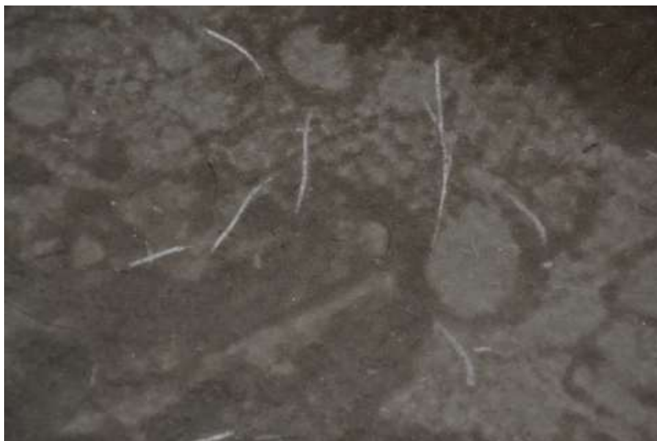
Figur 2.13 Hårdbetong Intercrete på parkeringsdäcket i Åkeshov 2018
