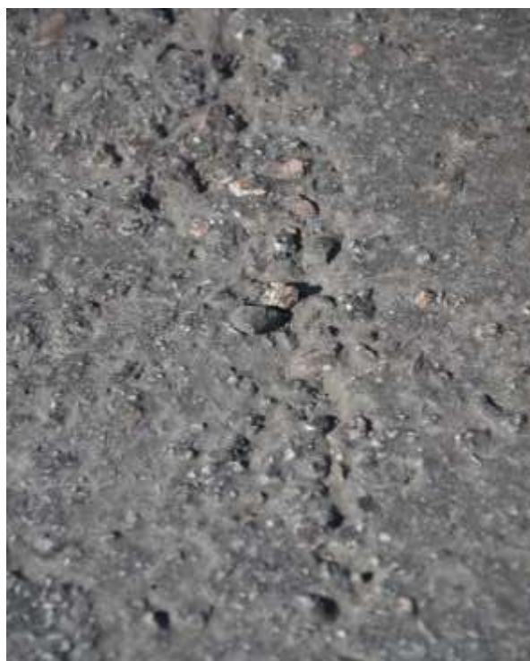
Figur 2.33 Gjutasfalt PGJA 11 med en del stensläpp efter drygt 3 år på parkeringsdäcket i Baggen
