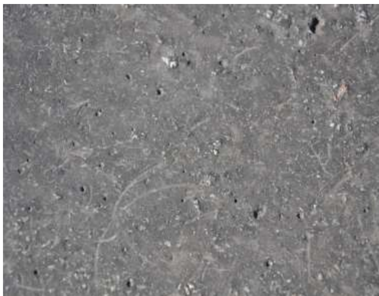
Figur 2.32 Gjutasfalt PGJA 11 på parkeringsdäcket i Baggen 2018
