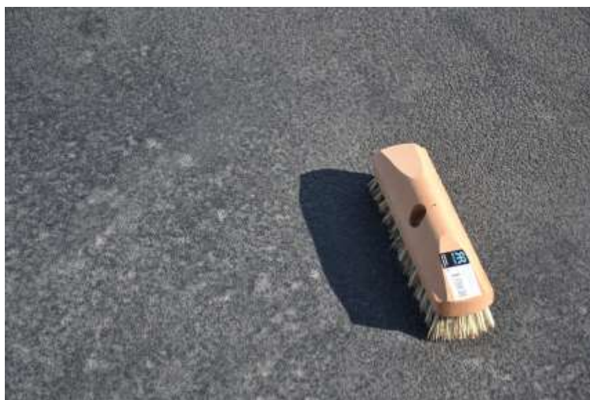
Figur 2.28 Polyurea Purtop på parkeringsdäcket i Baggen 2018
