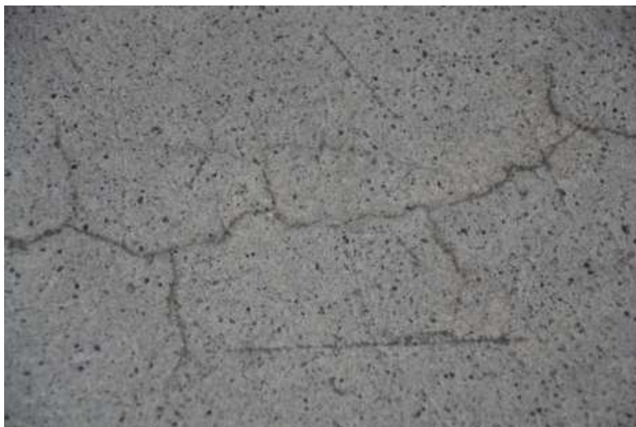
Fig 2.34 Hårdbetong Sikafloor-1 Corcrete på parkeringsdäcket i Baggen 2018
