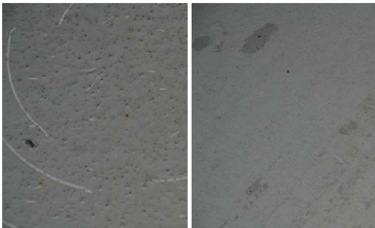
Figur 2.6 Ytligt slitage efter dubbdäck på Polyuretan Sikafloor efter 5 år på parkeringsdäcket i Kville
