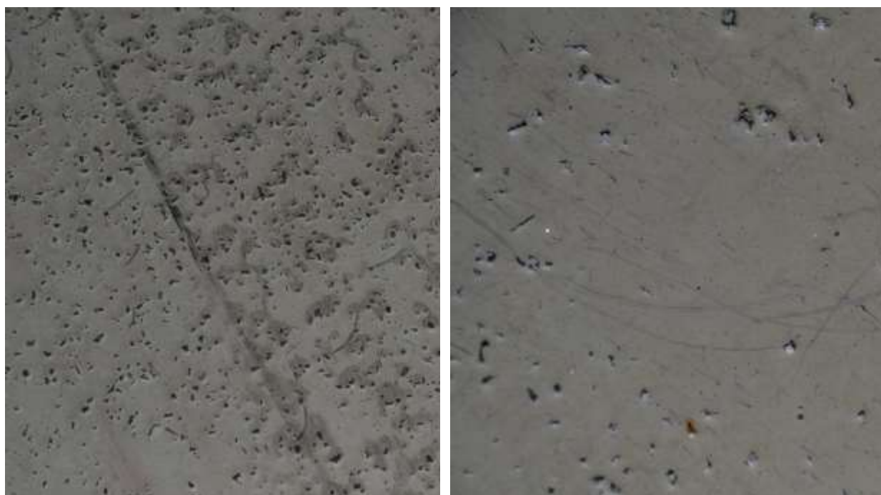
Figur 2.8 Ytligt slitage efter dubbdäck på Polyuretan StoCretec efter 5 år på parkeringsdäck i Kville
