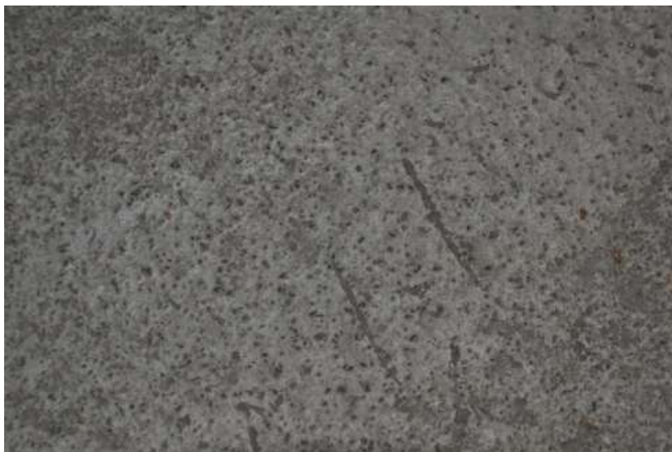
Figur 2.11 Polyuretan Conideck 2255 på parkeringsdäcket i Kville 2018
