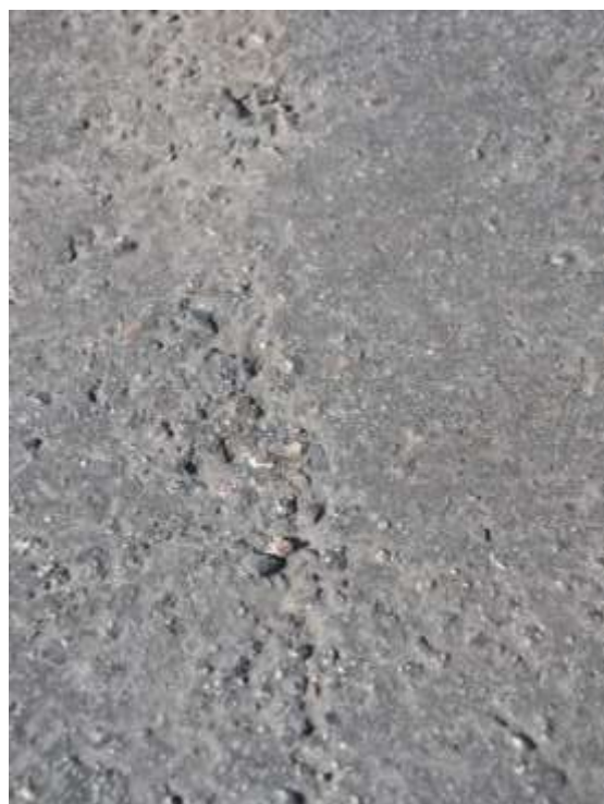
Figur 2.33 Gjutasfalt PGJA 11 med en del stensläpp efter drygt 3 år på parkeringsdäcket i Baggen
