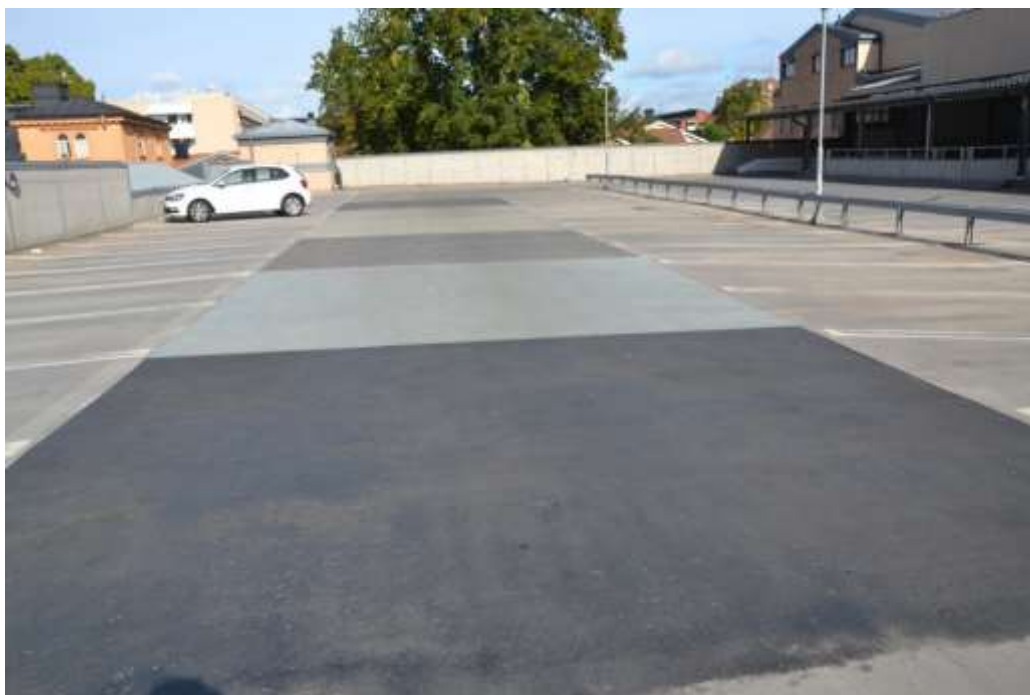
Figur 2.27 Parkeringsdäcket på Baggen 2018
