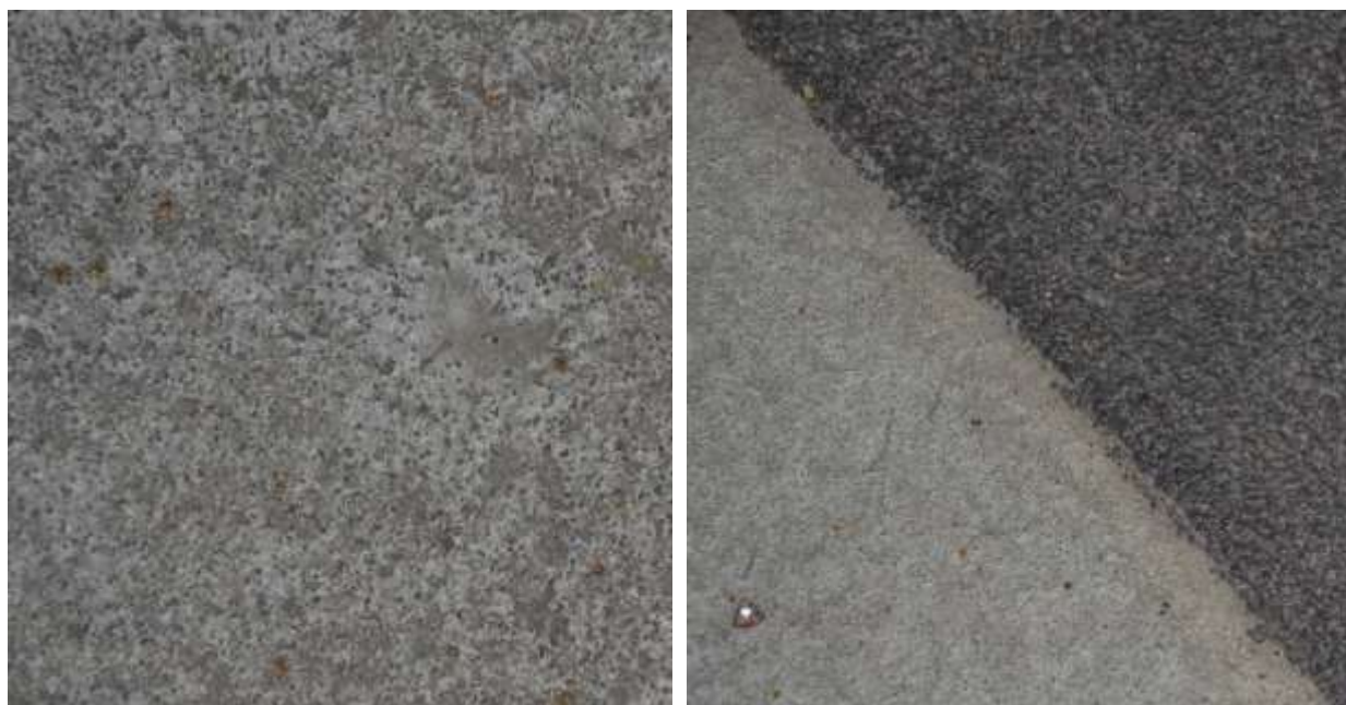
Figur 2.12 Ytligt slitage efter dubbdäck på Polyuretan Conideck 2255 efter 5 år på parkeringsdäcket i Kville
