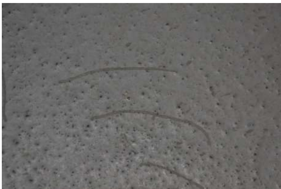
Figur 2.9 Polyuretan Deckshield ID på parkeringsdäcket i Kville 2018
