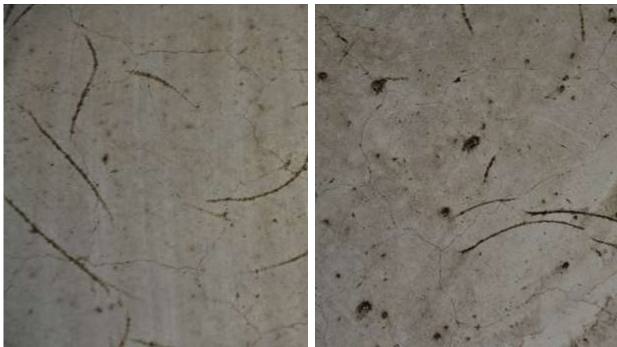
Figur 2.22 Ytligt slitage efter dubbdäck på Hårdbetong Mastertop efter 4 år på parkeringsdäcket i Åkeshov
