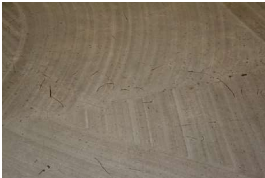
Figur 2.21 Hårdbetong Mastertop på parkeringsdäcket i Åkeshov 2018
