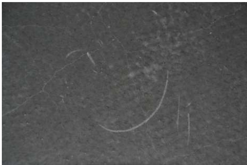
2.3 Hårdbetong Densit på parkeringsdäcket i Kville 2018
