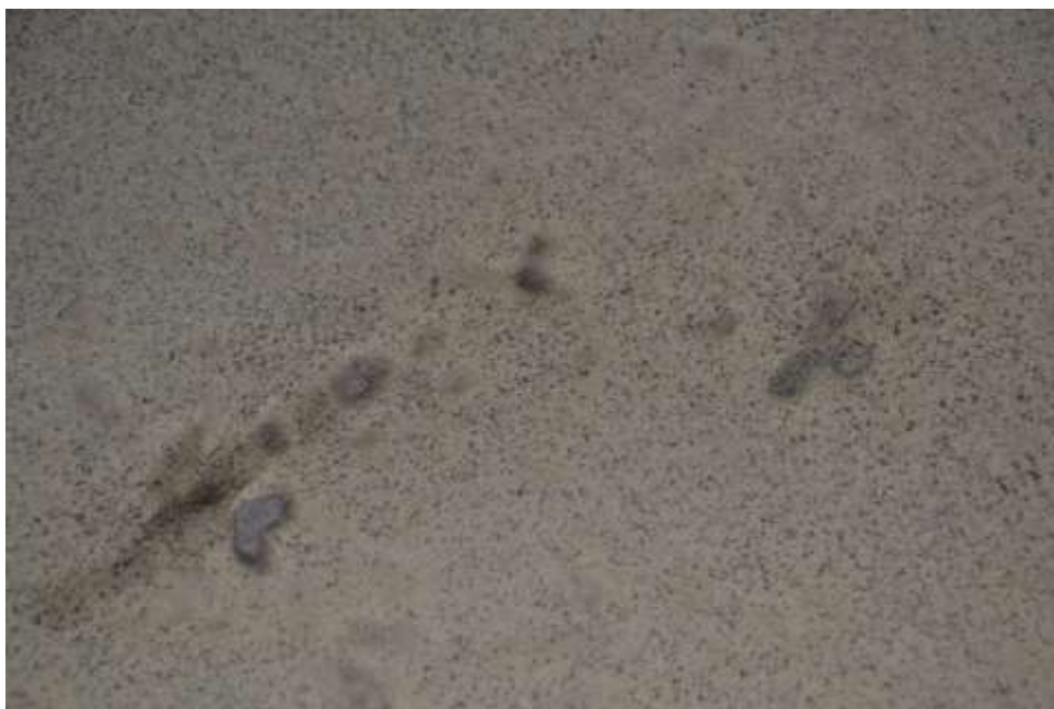
Figur 2.15 Polyurea Micorea på parkeringsdäcket i Kville 2018
