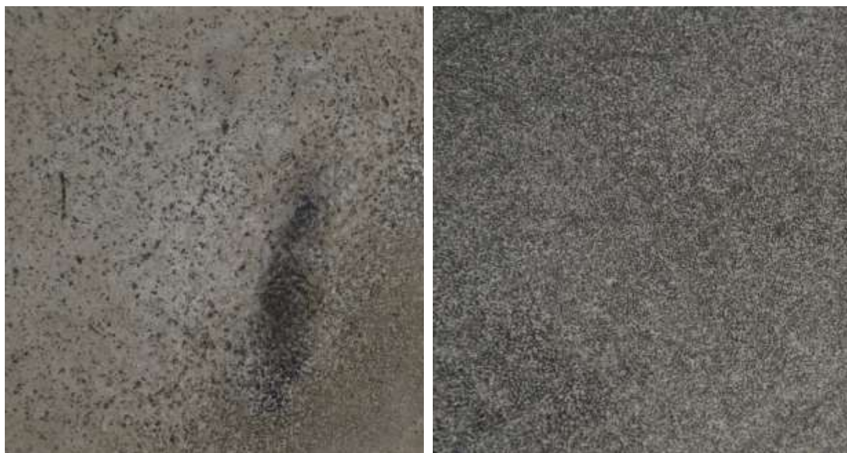
Figur 2.16 Gropar och ytligt slitage efter dubbdäck på Polyurea Micorea S3 efter 5 år på parkeringsdäcket i Kville
