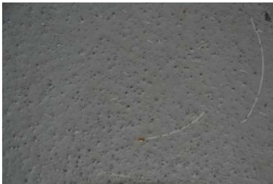
Figur 2.5 Polyuretan Sikafloor på parkeringsdäcket i Kville 2018
