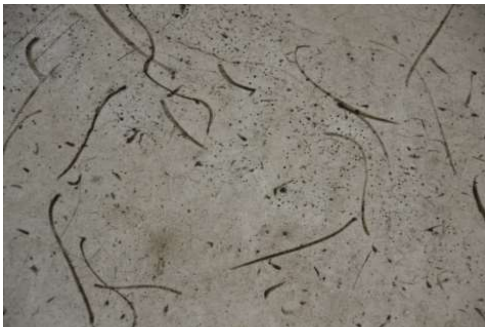
Figur 2.23 Epoxi Micopox på parkeringsdäcket i Åkeshov 2018
