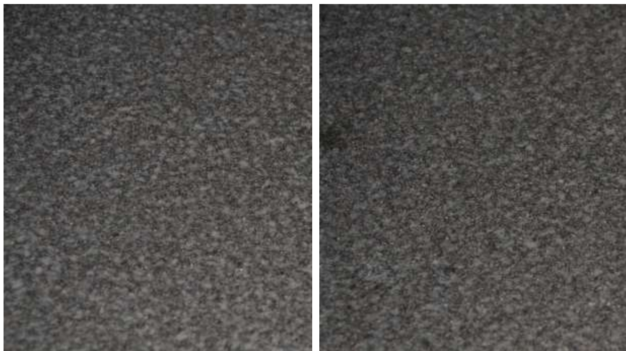
Figur 2.14 Ytligt slitage efter dubbdäck på Akryl Map Pro efter 5 år på parkeringsdäcket i Kville
