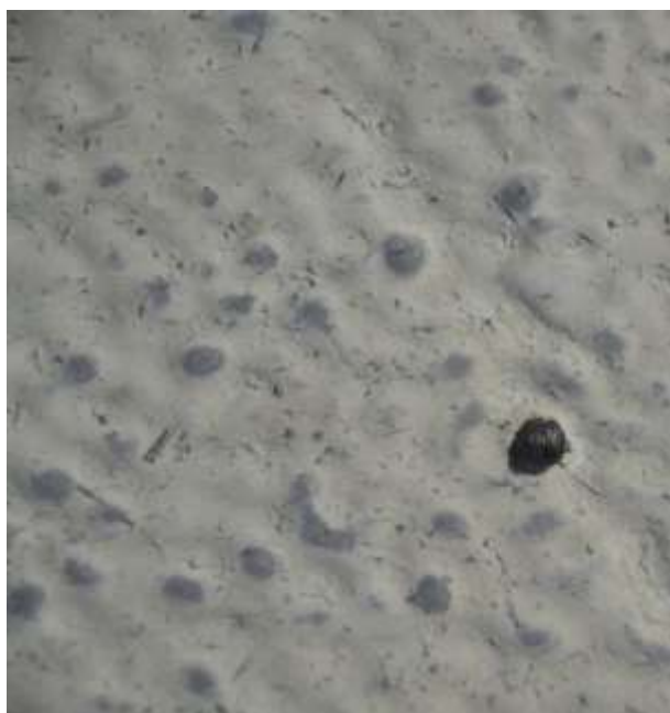
Figur 2.33 Polyurea Micorea HS med vidhäftningsförlust och gropar efter drygt 3 år på parkeringsdäcket i Baggen
