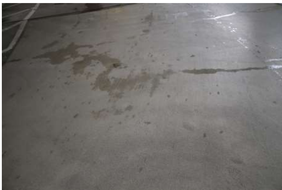
Figur 2.17 Polyuretan Mapefloor PU på parkeringsdäcket i Kville 2018
