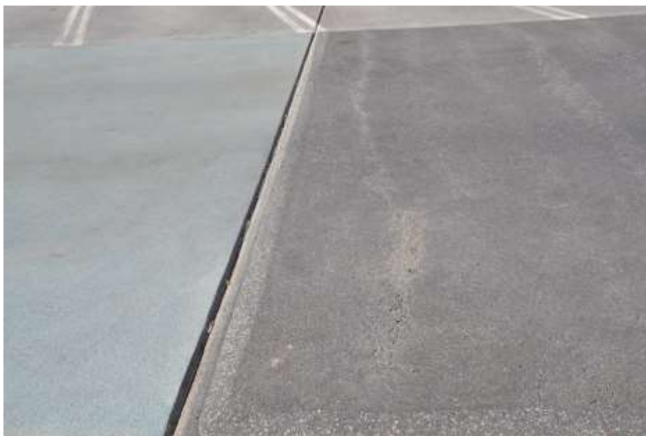
Figur 2.30 Akryl Silikal på parkeringsdäcket i Baggen 2018
