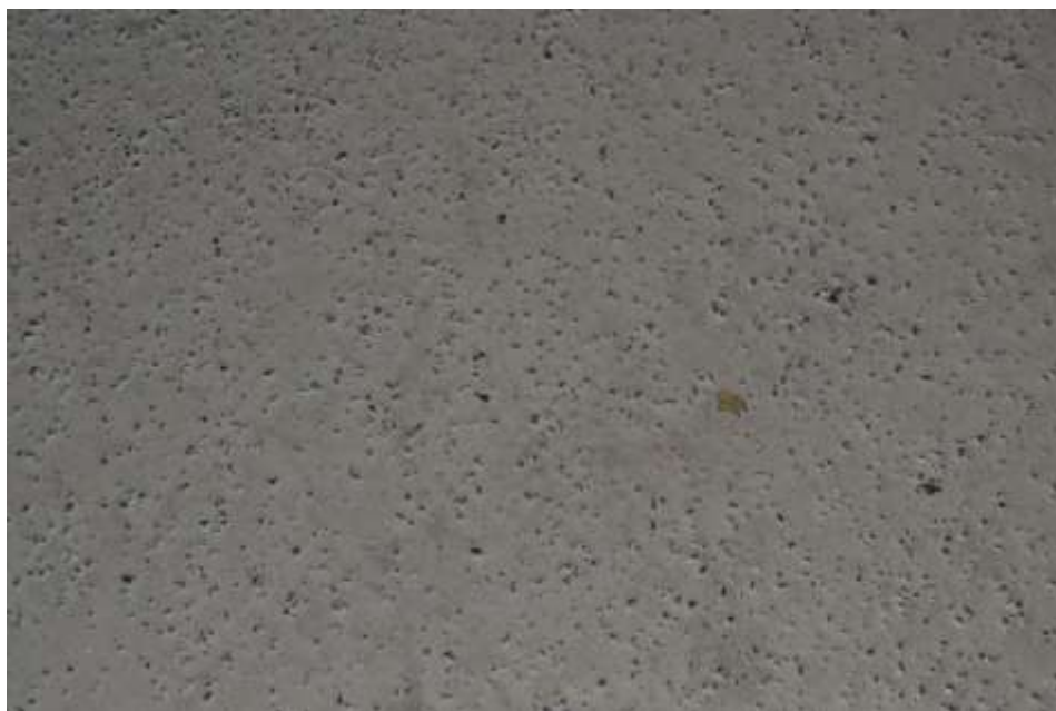
Figur 2.7 Polyuretan StoCretec på parkeringsdäcket i Kville 2018
