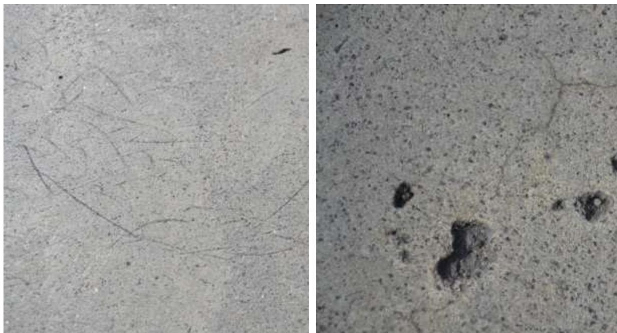
Figur 2.35 Hårdbetong Sikafloor-1 Corcrete med ytligt slitage och gropar efter drygt 3 år på parkeringsdäcket i Baggen
