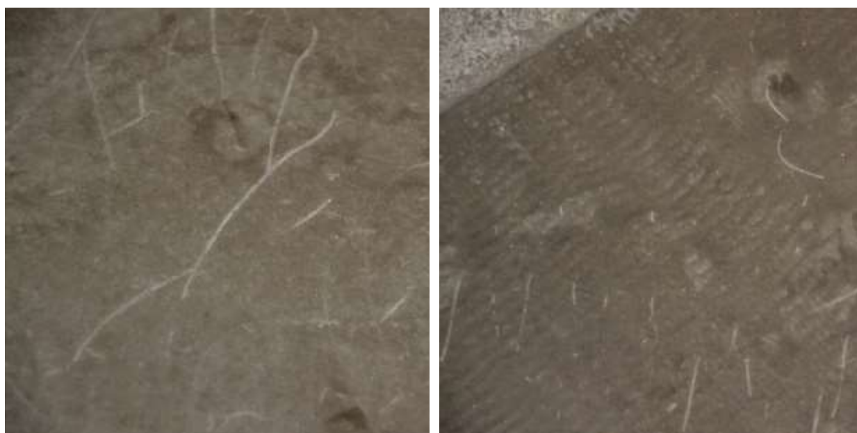
Figur 2.14 Ytligt slitage från dubbdäck på Hårdbetong Intercrete efter 4 år på parkeringsdäcket i Åkeshov
