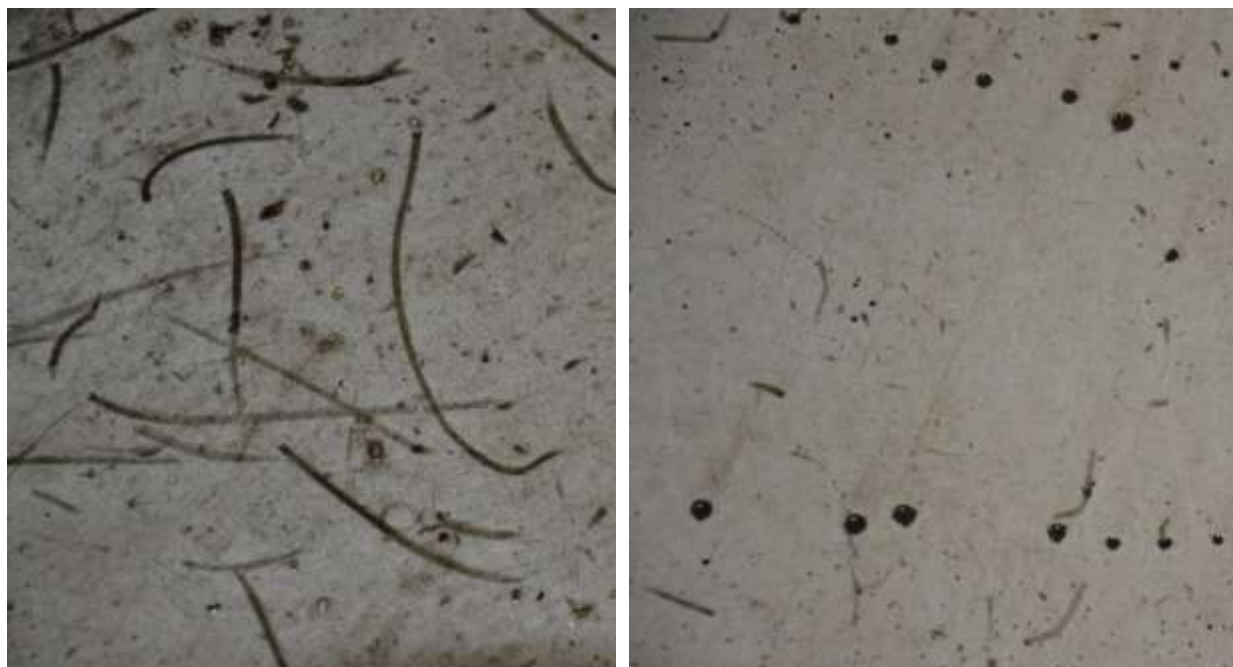
Figur 2.24 Ytligt slitage efter dubbdäck och blåsor på Epoxi Micopox efter 4 år på parkeringsdäcket Åkeshov
