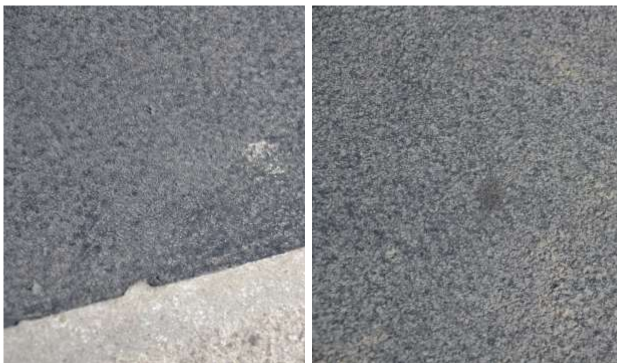
Figur 2.29 Polyurea Purtop med liten vidhäftningsförlust i kant och ytligt slitage efter drygt 3 år på parkeringsdäcket i Baggen
