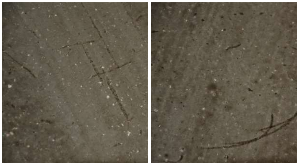
Figur 2.20 Ytligt slitage efter dubbdäck på Polyuretan Ucrete efter 4 år på parkeringsdäcket i Åkeshov
