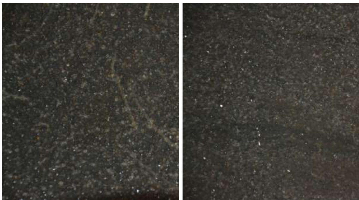
Figur 2.18 Ytligt slitage efter dubbdäck på Akryl Duracon efter 4 år på parkeringsdäcket i Åkeshov
