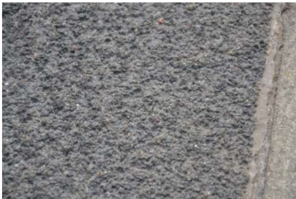
Figur 2.36 Akryl Duracon på parkeringsdäcket i Baggen 2018
