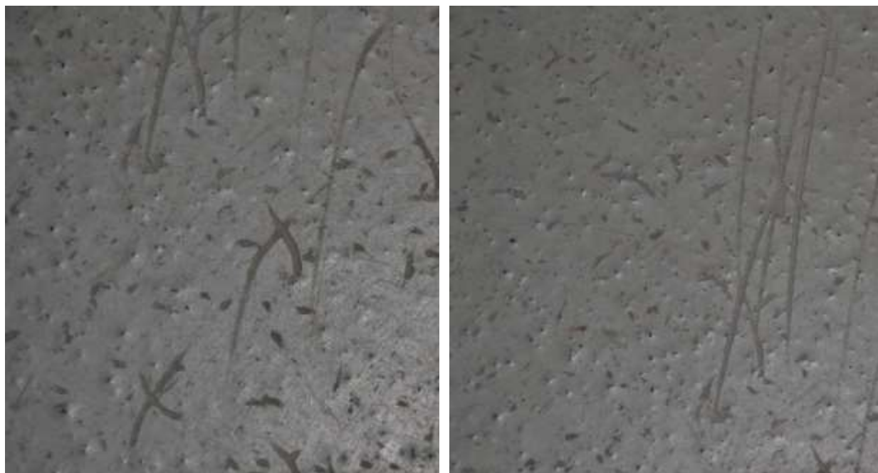
Figur 2.10 Ytligt slitage efter dubbdäck på Polyuretan Deckshield ID efter 5 år på parkeringsdäcket i Kville
