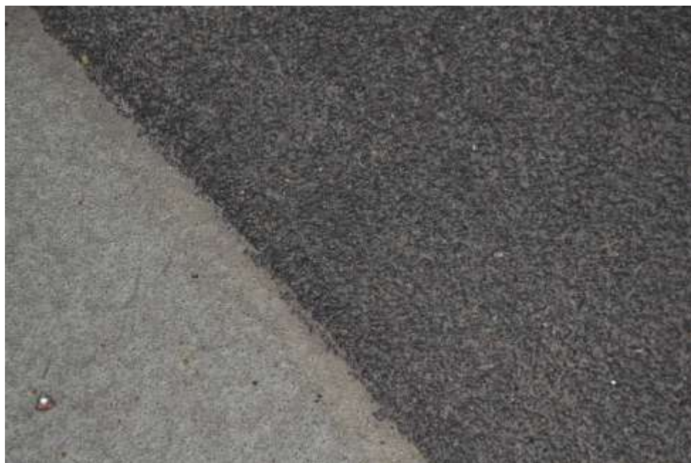
Figur 2.13 Akryl Map Pro på parkeringsdäcket i Kville 2018
