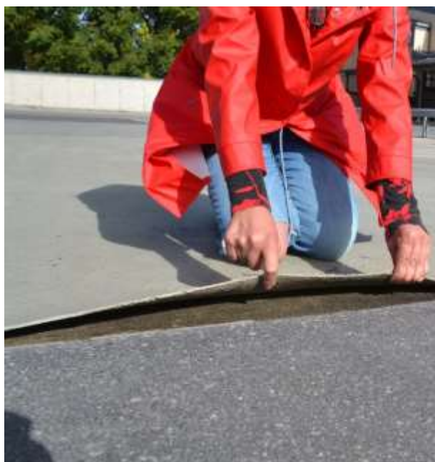
Figur 2.33 Polyurea Micorea HS med vidhäftningsförlust och gropar efter drygt 3 år på parkeringsdäcket i Baggen
