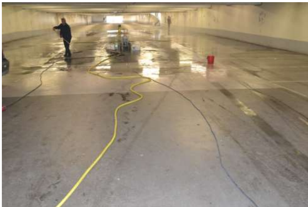
Figur 2.12 Parkeringsdäcket i Åkeshov 2018. Väggar och tak skulle målas om. Provytorna var därför våta vid inspektionen.
